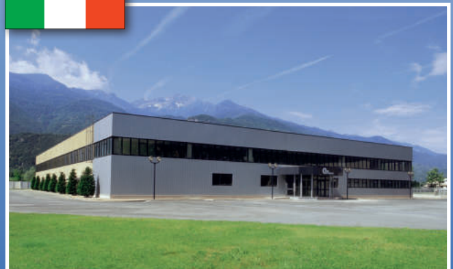
AUTOBLOK Werk in Caprie-Torino
