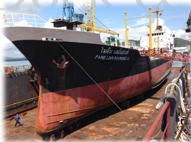
งานซ่อมบำรุงเรือบรรทุกน้ำมัน
