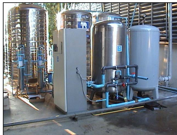
ชุดผลิตน้ำโอโซนล้างฆ่าเชื้อโรค ในกระบวนการผลิต โรงงาน บริษัท เชียงใหม่ เฟรชมิลค์ จำกัด
