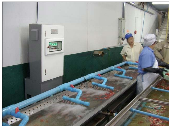
อ่างล้างน้ำโอโซนฆ่าเชื้อโรค โรงงานหลวงดอยคำ
